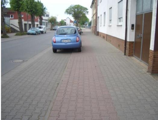
**Bild 4:** Trennung Geh-/Radweg durch farbiges Pflaster (Rheingaustraße)
