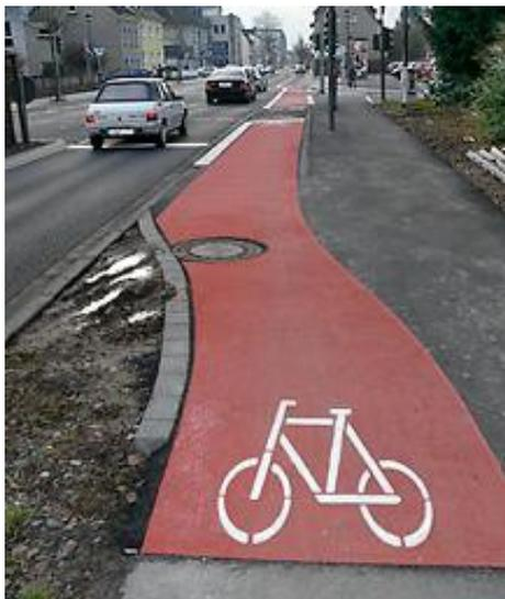
**Bild 38:** Übergang Fuß-/Radweg auf Schutzstreifen mittels Rampe in Köln [17]
