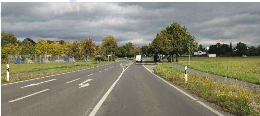
Abbildung 2.2: Kreisverkehr K 126 (Blick nach Norden)
