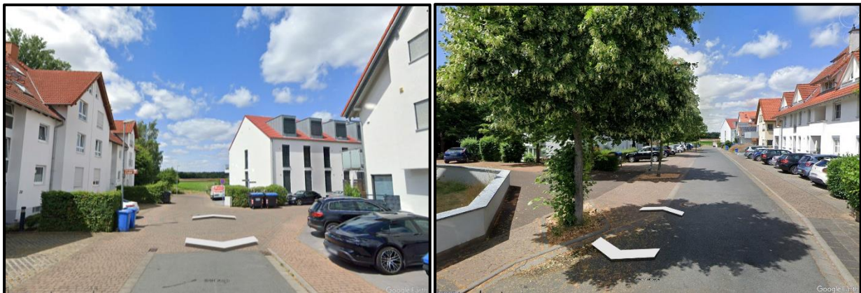
Abbildung 3: Ansicht in der Schweriner Straße, Blickrichtung nach Westen Bild Links: Bereich Einmündung in die Vielauer Straße; Bild rechts: Bereich Einmündung in den Erschließungsweg zum Plangebiet (nach links)
